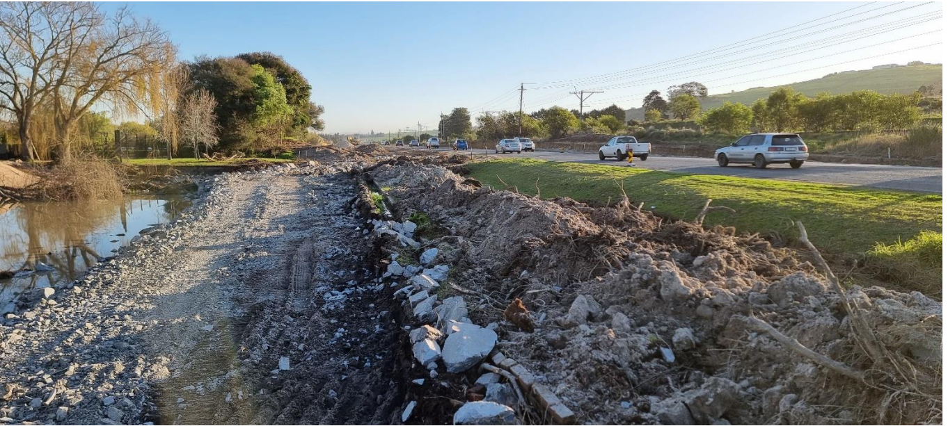
Spier Dam rockfill
